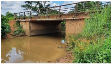
Photos 49: Pont-Cadre (PSIBA)-8.5 m
