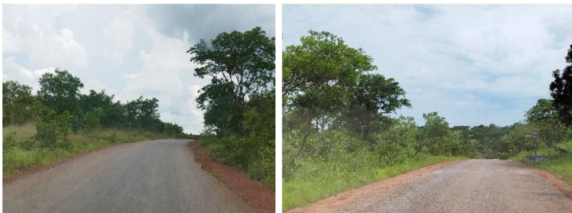
Photos 36: PK17+200 et PK208: points hauts et absence de visibilité à corriger
