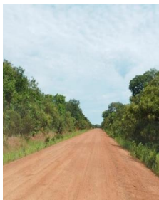
Photos 18: PK184-arrachement de la totalité de la couche de surface
