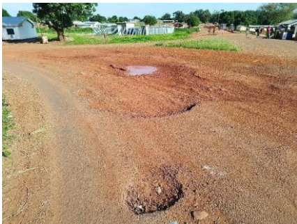
Photos 26: PK136 et PK137, nids de poule de faible profondeur et de surface importante
