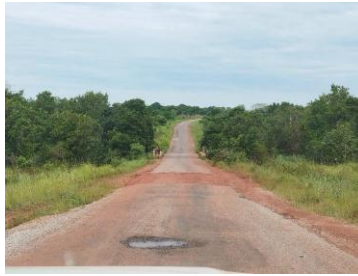
Photos 17: PK152 et PK175-arrachement d'une partie de la couche de surface
