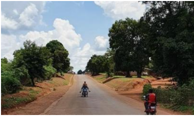
Photos 45: Fossés trapézoïdaux bétonnés et en
