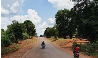
Photos 45: Fossés trapézoïdaux bétonnés et en
