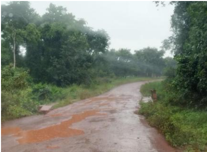
Photos 13: PK 54, nid de poule de grande profondeur très étendue important
