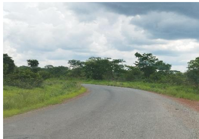
Photos 33:PK26 et PK38+700-Succession de rayons nécessitant une amélioration du tracé
