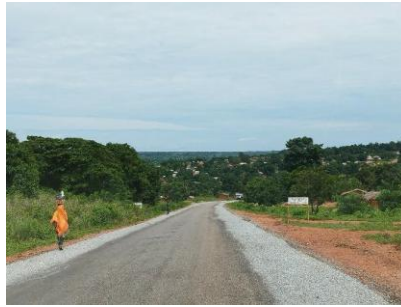
Photos 30:PK225-rechargement des accotements
