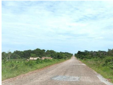
Photos 28:PK216-nids de poule récemment réparés d'eau
