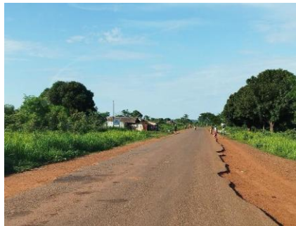
Photos 22:PK137,sortie de Bossempaté,stationnement des PL et formation des detelles de rive
