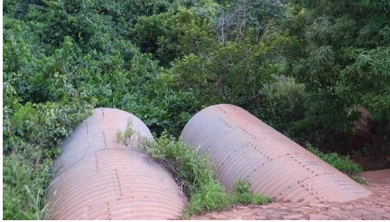
Photos 41: 2 Buses métalliques de diamètre 3000
