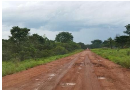
Photos 8: PK47 et PK122 - arrachement de la totalité de la couche de surface
