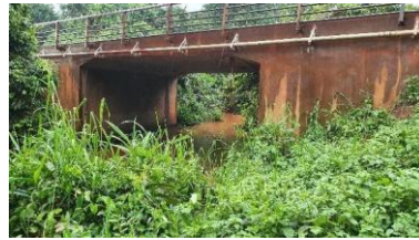
Photos 50: Pont-Cadre (PSIBA)-9 m
