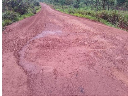
Photos 11: PK44 et 46 nids de poule de grande profondeur et de grande surface
