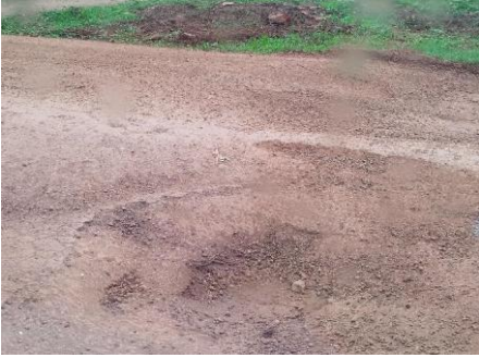
Photos 11: PK44 et 46 nids de poule de grande profondeur et de grande surface
