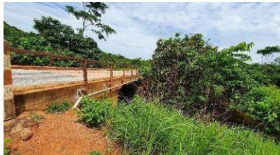
Photos 54: Pont-Cadre (PSIBA)-12 m
