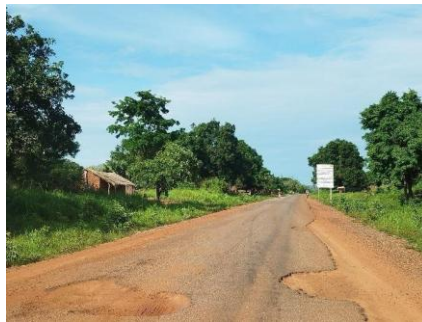
Photos 26: PK136 et PK137, nids de poule de faible profondeur et de surface importante
