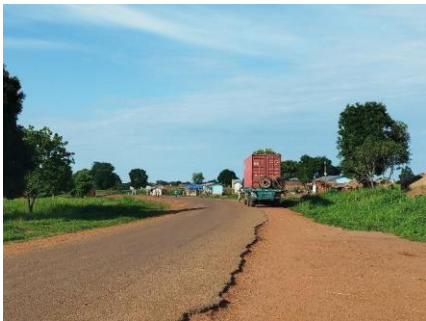
Photos 22:PK137,sortie de Bossempaté,stationnement des PL et formation des detelles de rive
