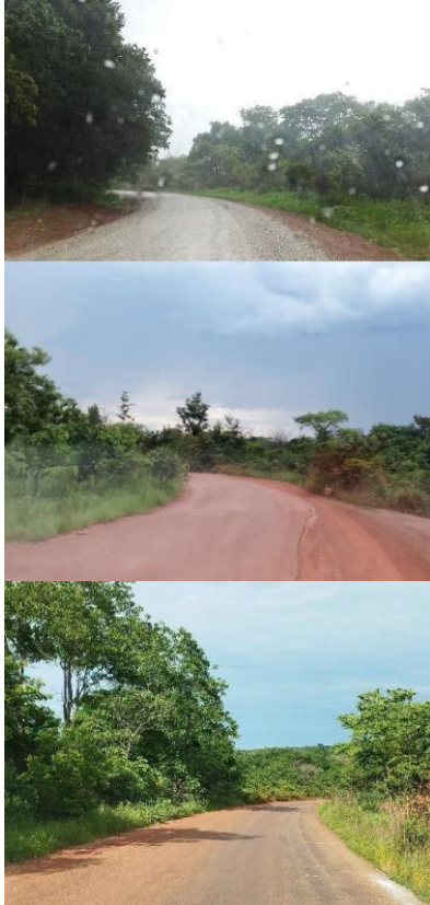
Photos 34: Exemples de virages serrés avec une visibilité réduite aux PK 20+200, 18+900, 41+400, 101+100, 148 et 155
