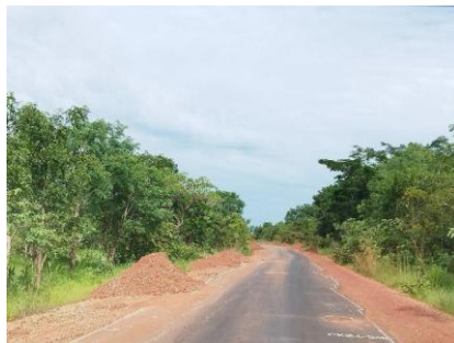
Photos 24:PK161-travaux de réparation des épaufures
