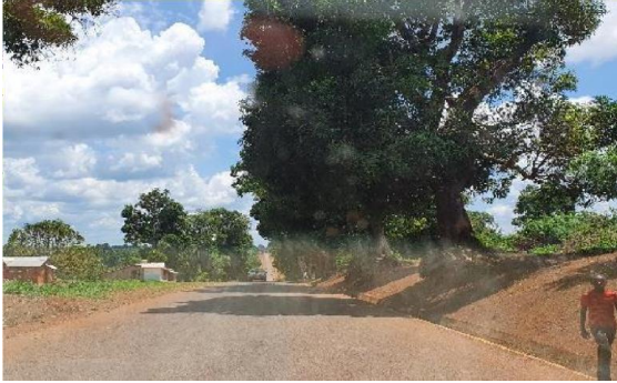
Photos 43: Fossé trapézoïdal bétonné
